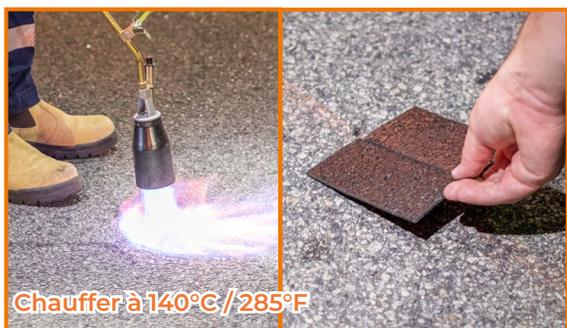
3. Dégagez l'emplacement de tout matériau non fixé afin de permettre un collage correct du patch.
