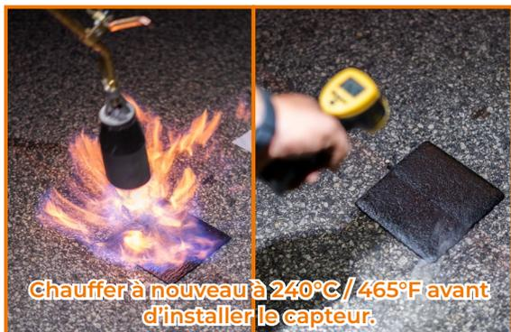
6. Utilisez le brûleur à gaz pour chauffer le patch à une **température finale d'au moins 240°C / 465°F**. Lorsque le patch est suffisamment chauffé, il doit avoir l'aspect d'un liquide visqueux et peut émettre une petite quantité de fumée. Le patch doit « fondre » dans toutes les rainures/fissures de la route pour assurer la longévité de l'installation.
