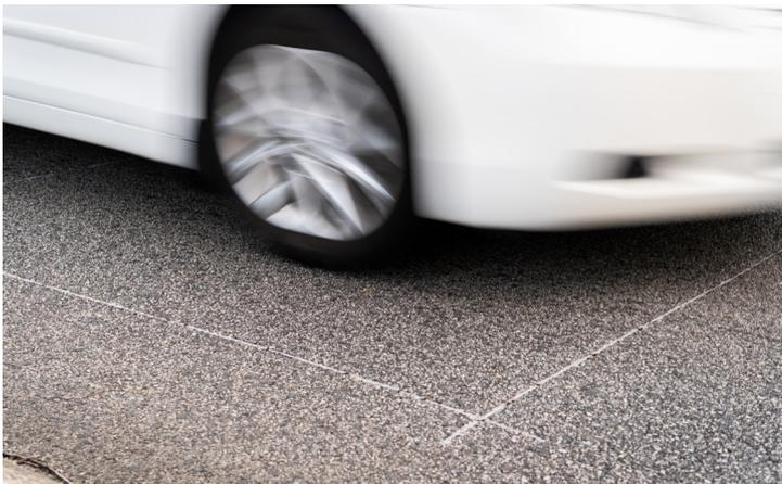
*Un detector de bucle de inducción por carril ofrece un volumen de datos exacto. 2 bucles ofrecen clasificación basados en la longitud & información de la velocidad.*
