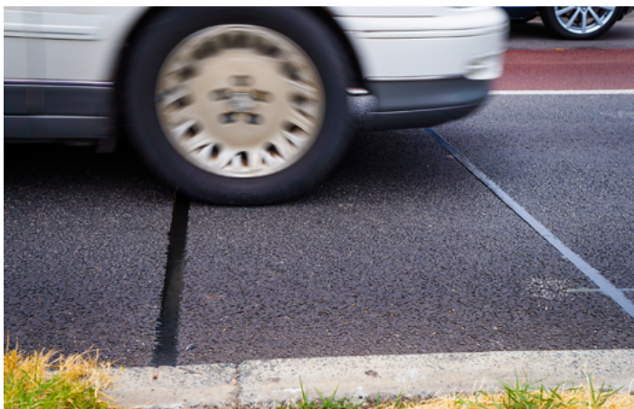
Les capteurs piézoélectriques sont très sensibles, discrets, durables et peuvent résister au déneigement.
